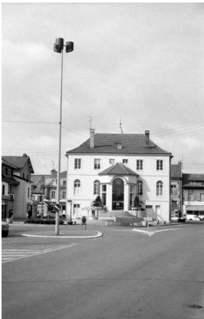
Vue de situation et façade postérieure.
