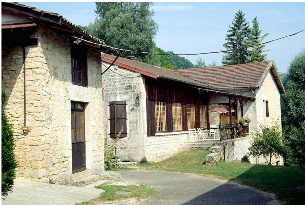
Façade postérieure du moulin et bâtiment (B).
