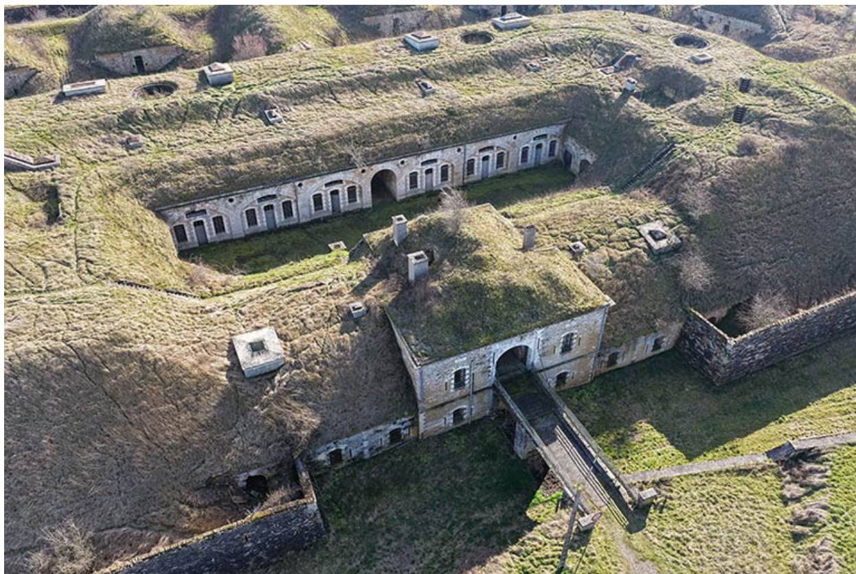
Le bâtiment d'entrée et l'espace de casernement. (vue aérienne).
