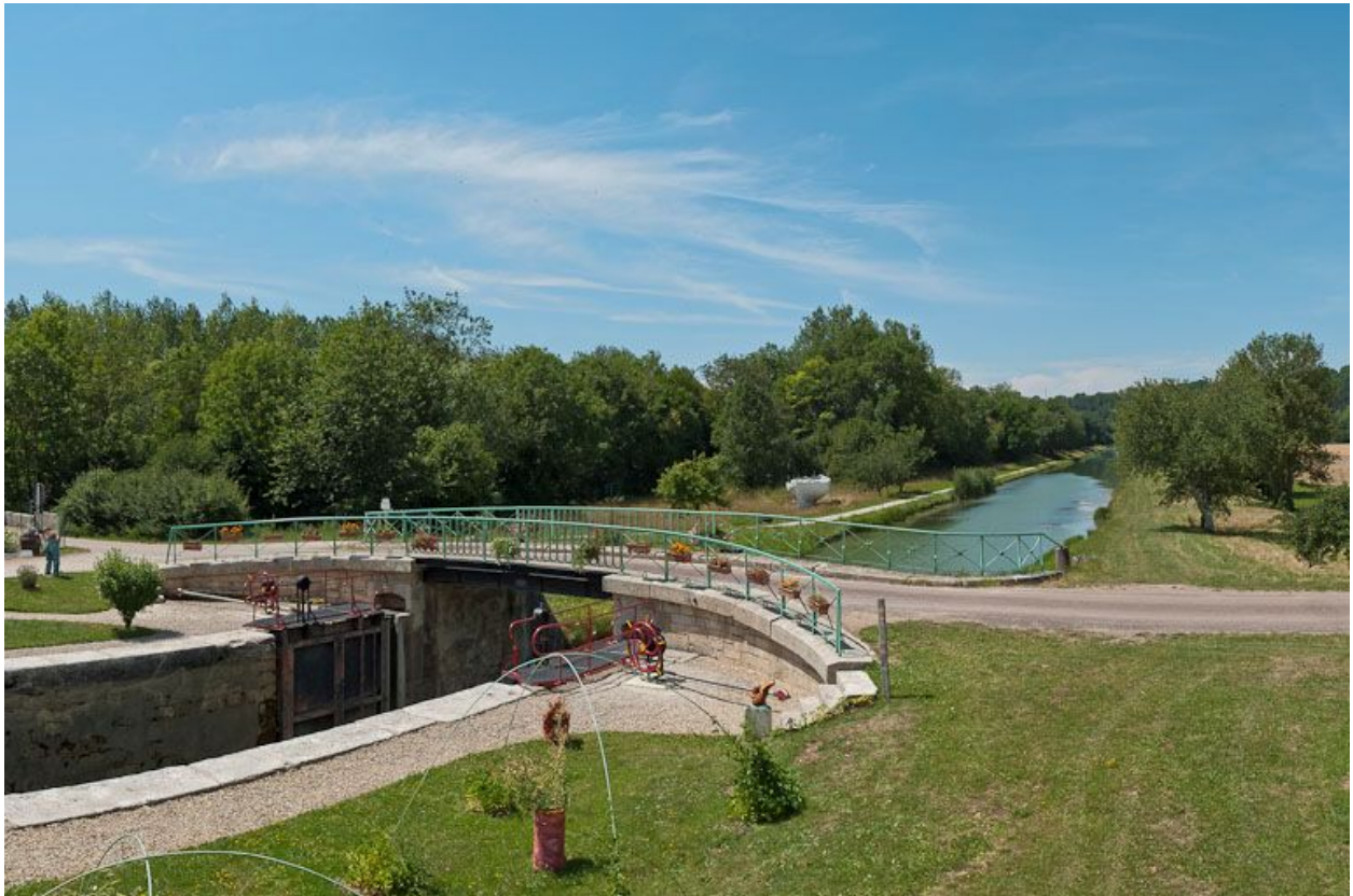
Vue du pont depuis l'amont.
