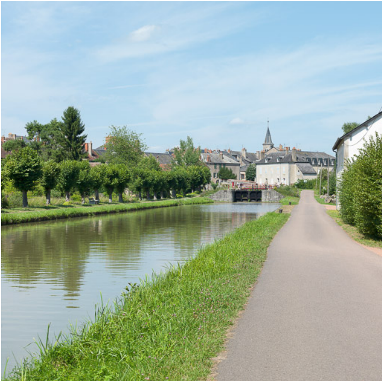
Vue du site d'écluse.
