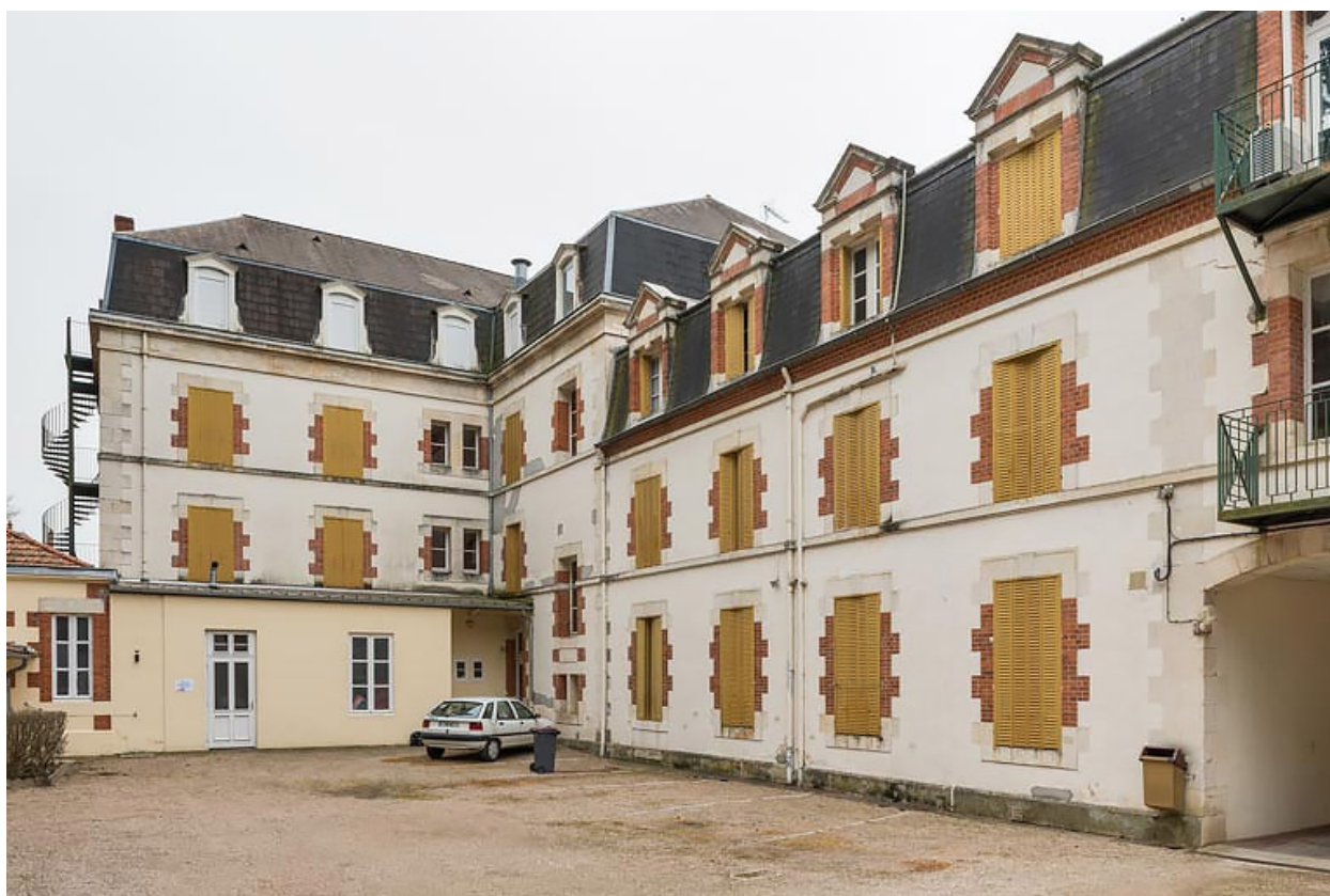
Façade sur la cour.
