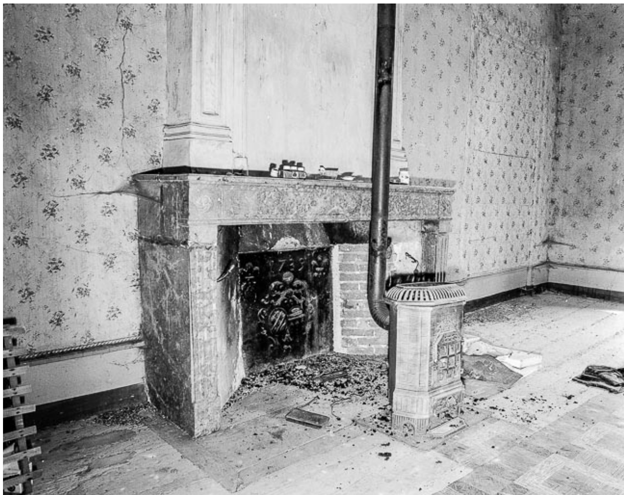
Corps de logis, cheminée.
