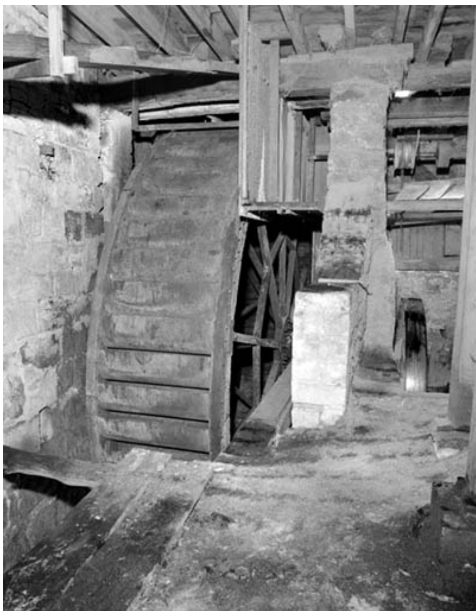
Bâtiment d'eau : la roue hydraulique.
