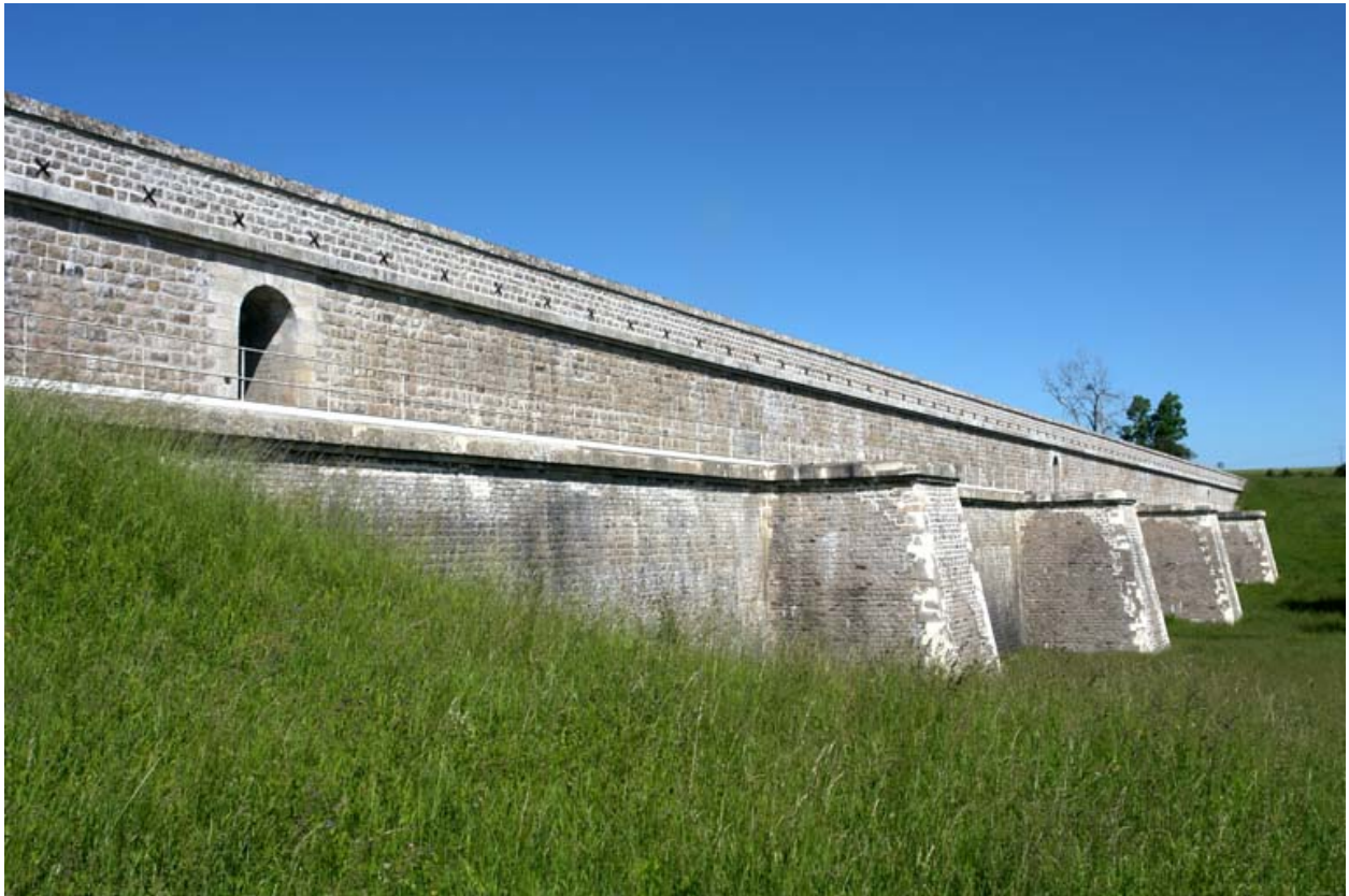
Face avant du barrage, vue d'ensemble.
