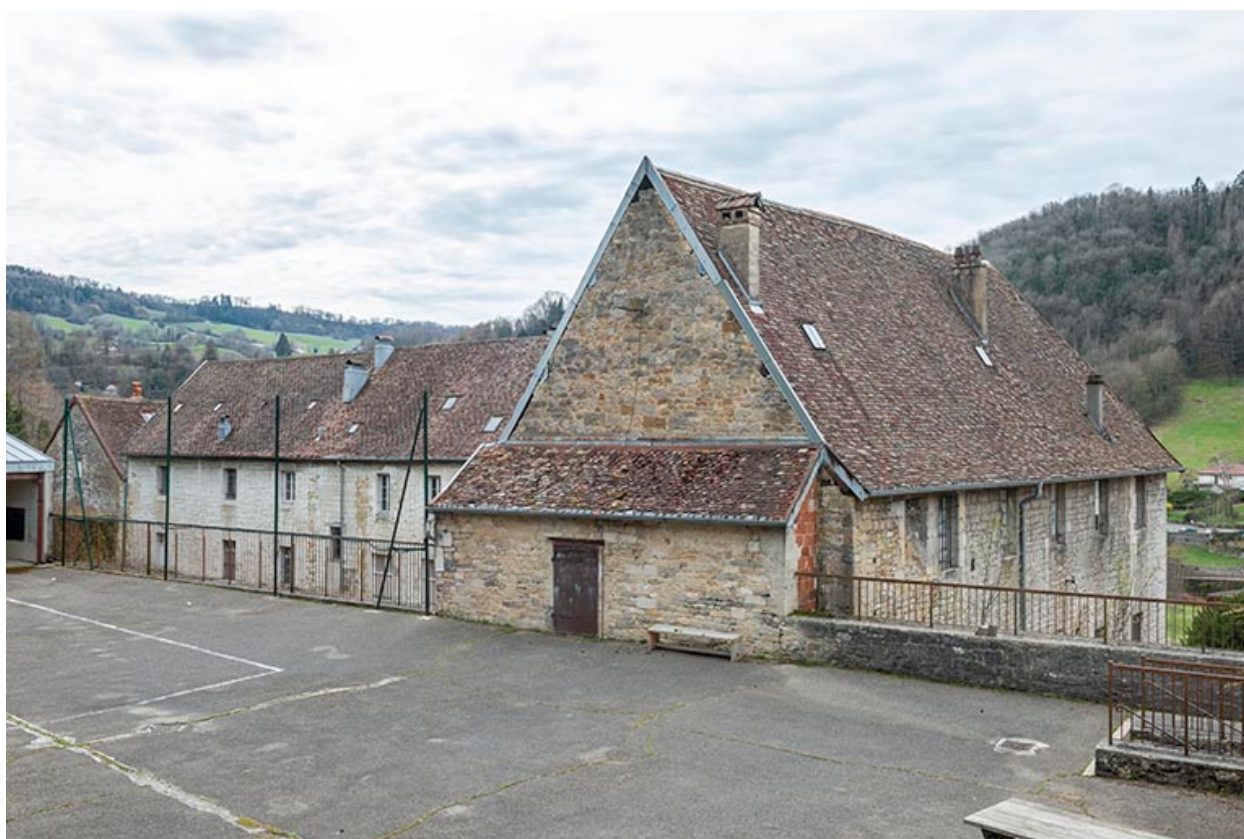
Vue d'ensemble depuis la terrasse, au nord-est.
