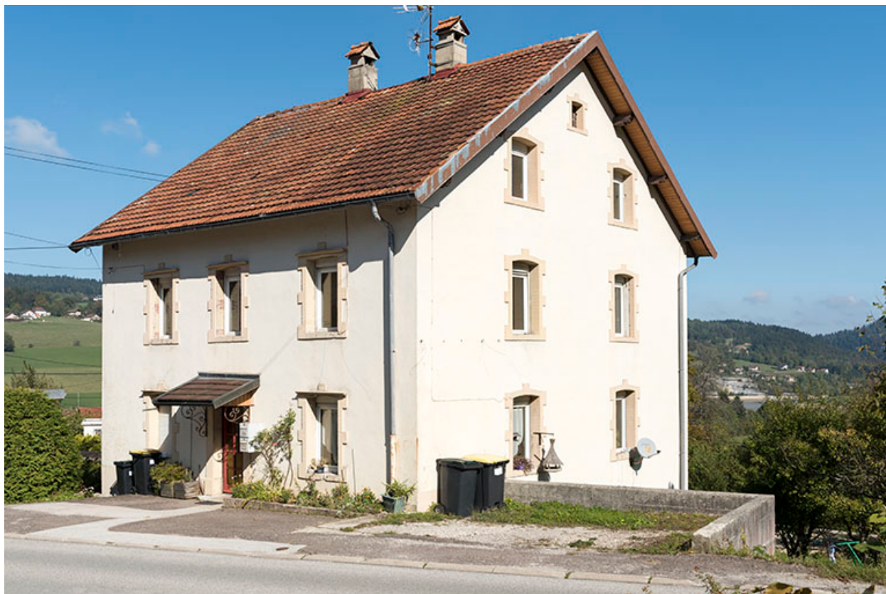
Façades antérieure et latérale droite.
