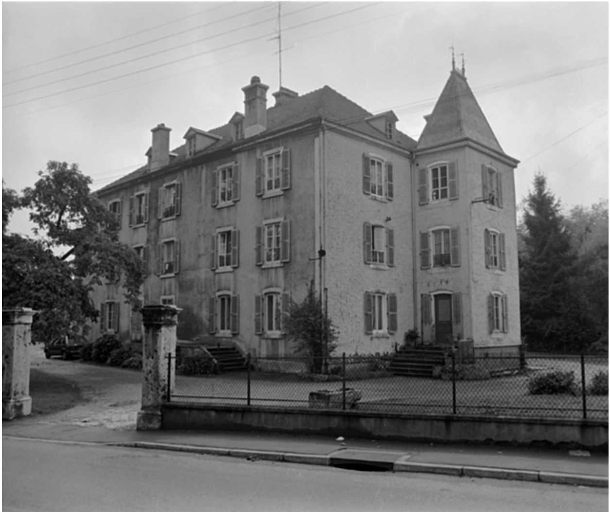
Vue de trois quarts droite en 1981.SRI. Enquête régionale sur les bâtiments industriels (1979-1981).
