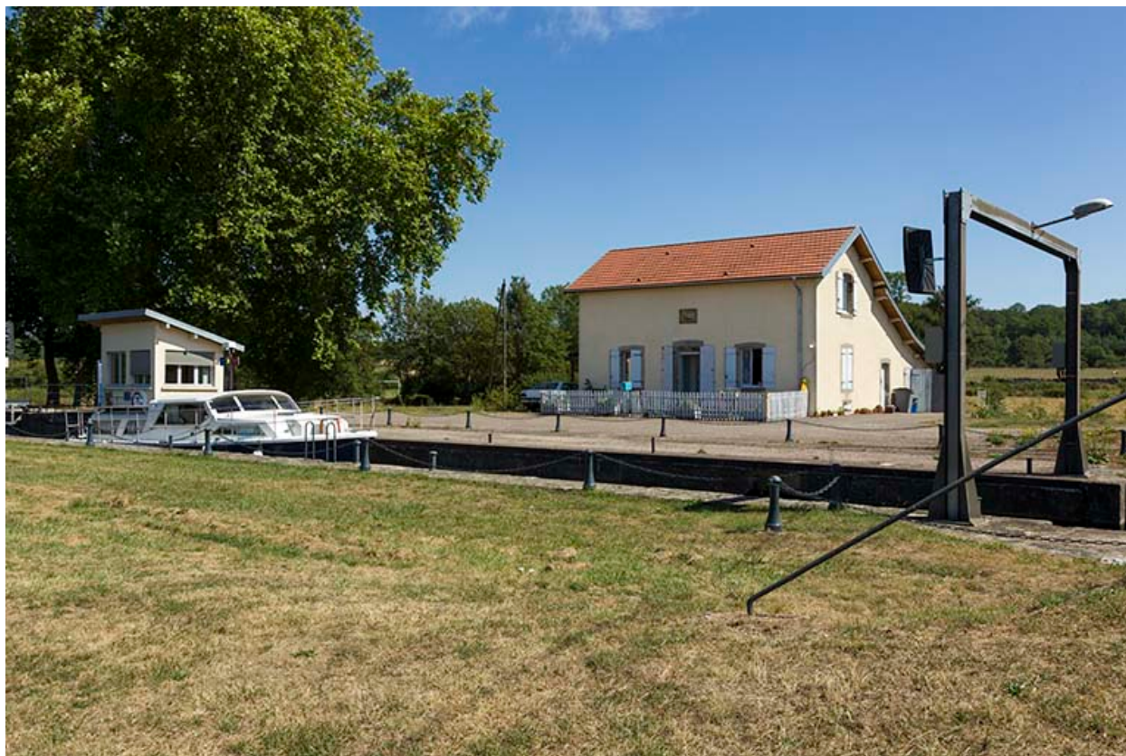
Le site d'écluse, vue d'ensemble.
