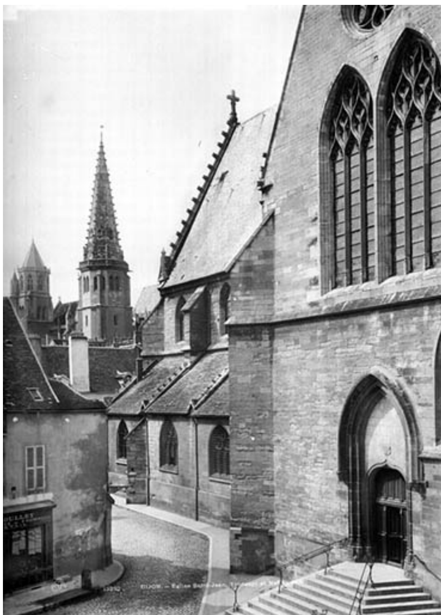
Façade sud : transept et partie ouest. 1905.
