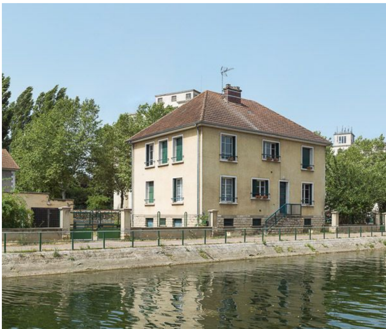
La maison éclusière, vue de 3/4.
