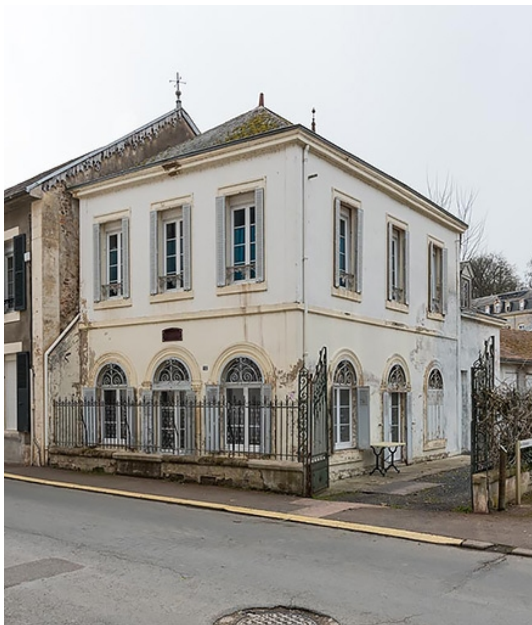
Façades sur l'avenue de la Libération.
