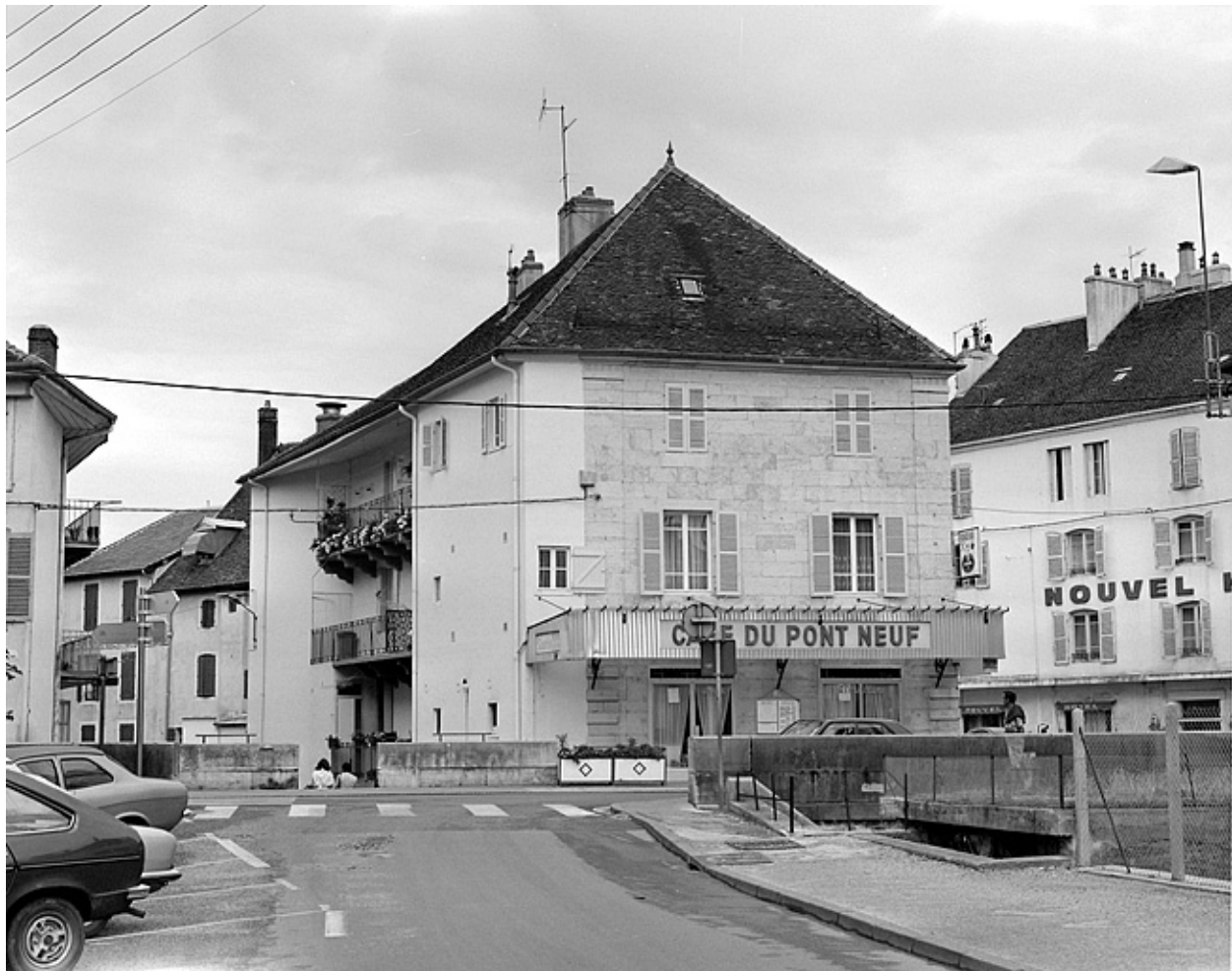
Façade latérale gauche.
