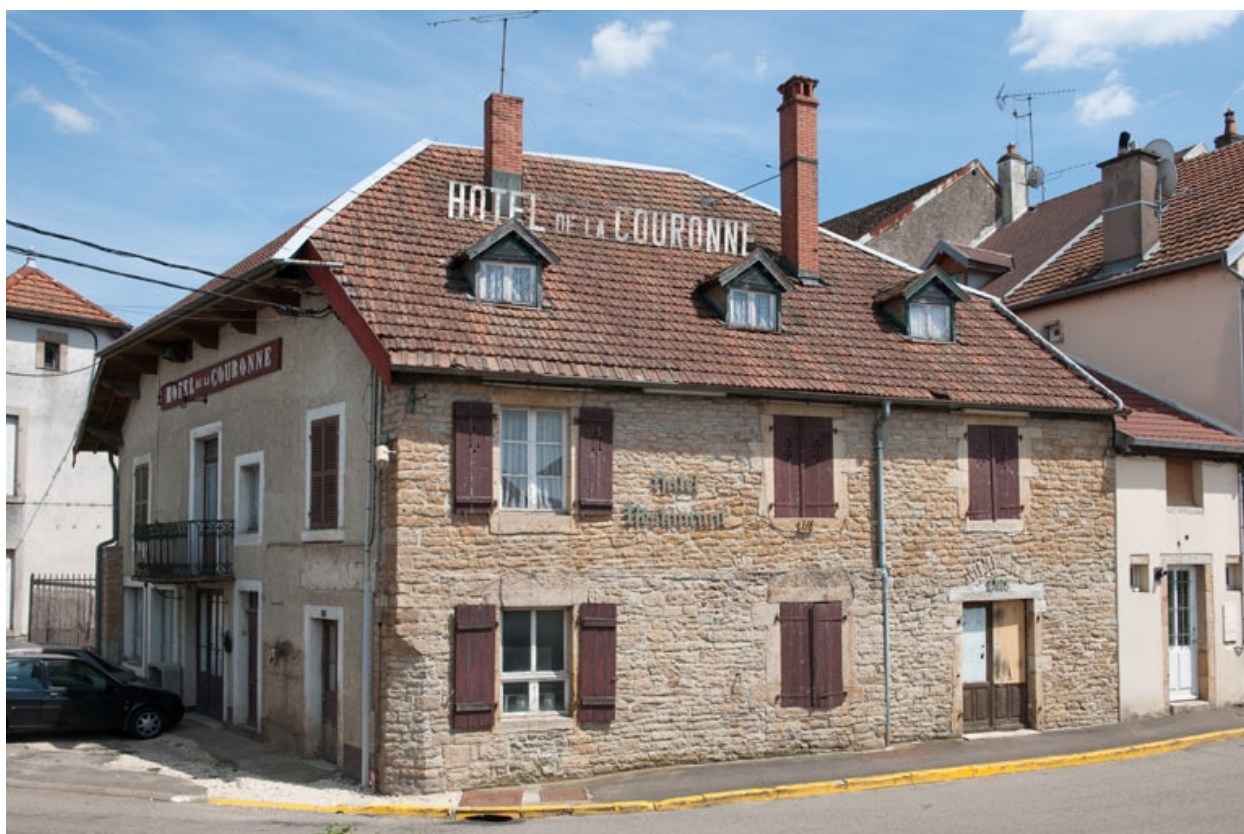
Façade antérieure et latérale droite.
