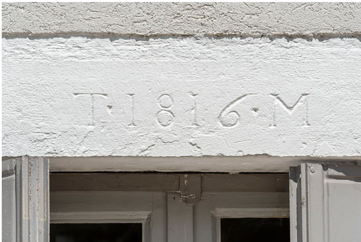
Ancienne ferme, façade antérieure : linteau daté 1816.
