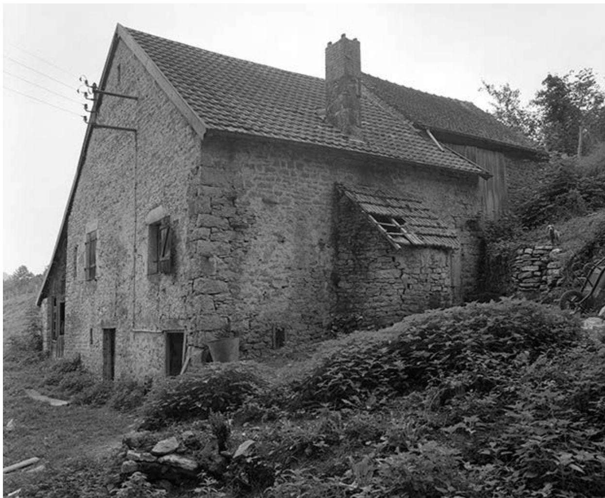
Façade antérieure et face latérale droite.
