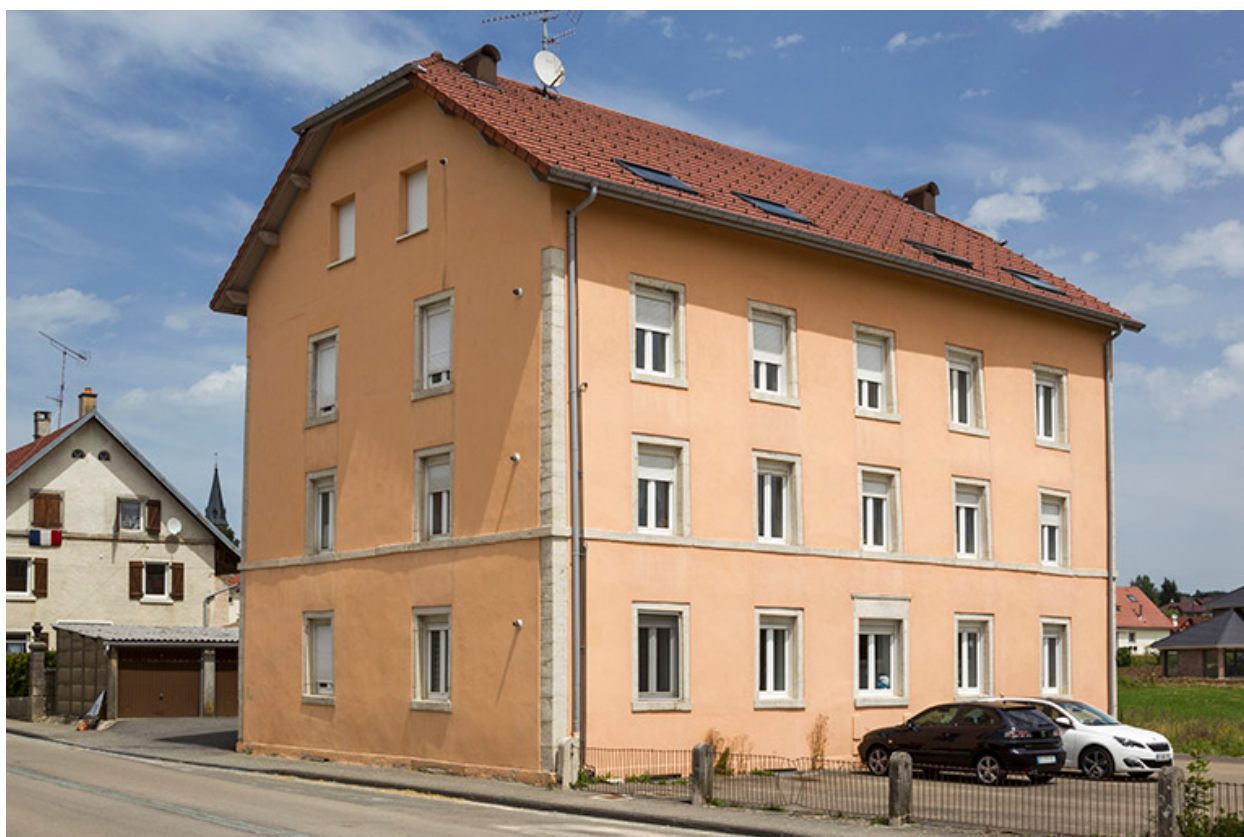
Façades postérieure et latérale droite.
