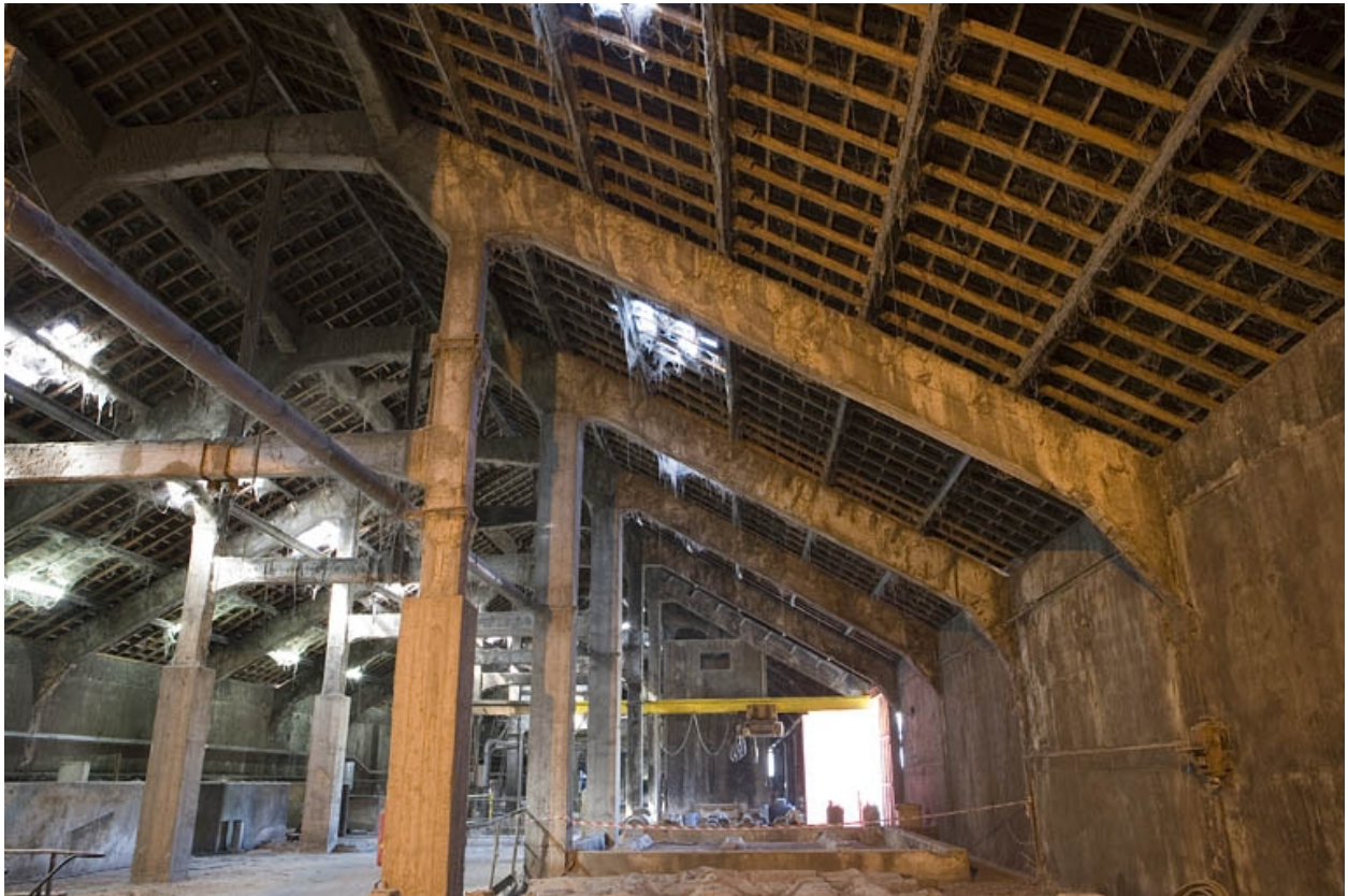
Atelier de trituration. Vue latérale de la charpente.
