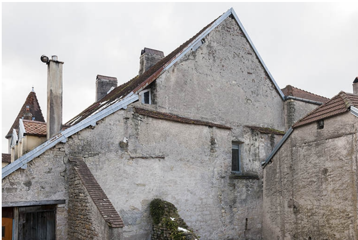
Façade postérieure côté rue Catinat.
