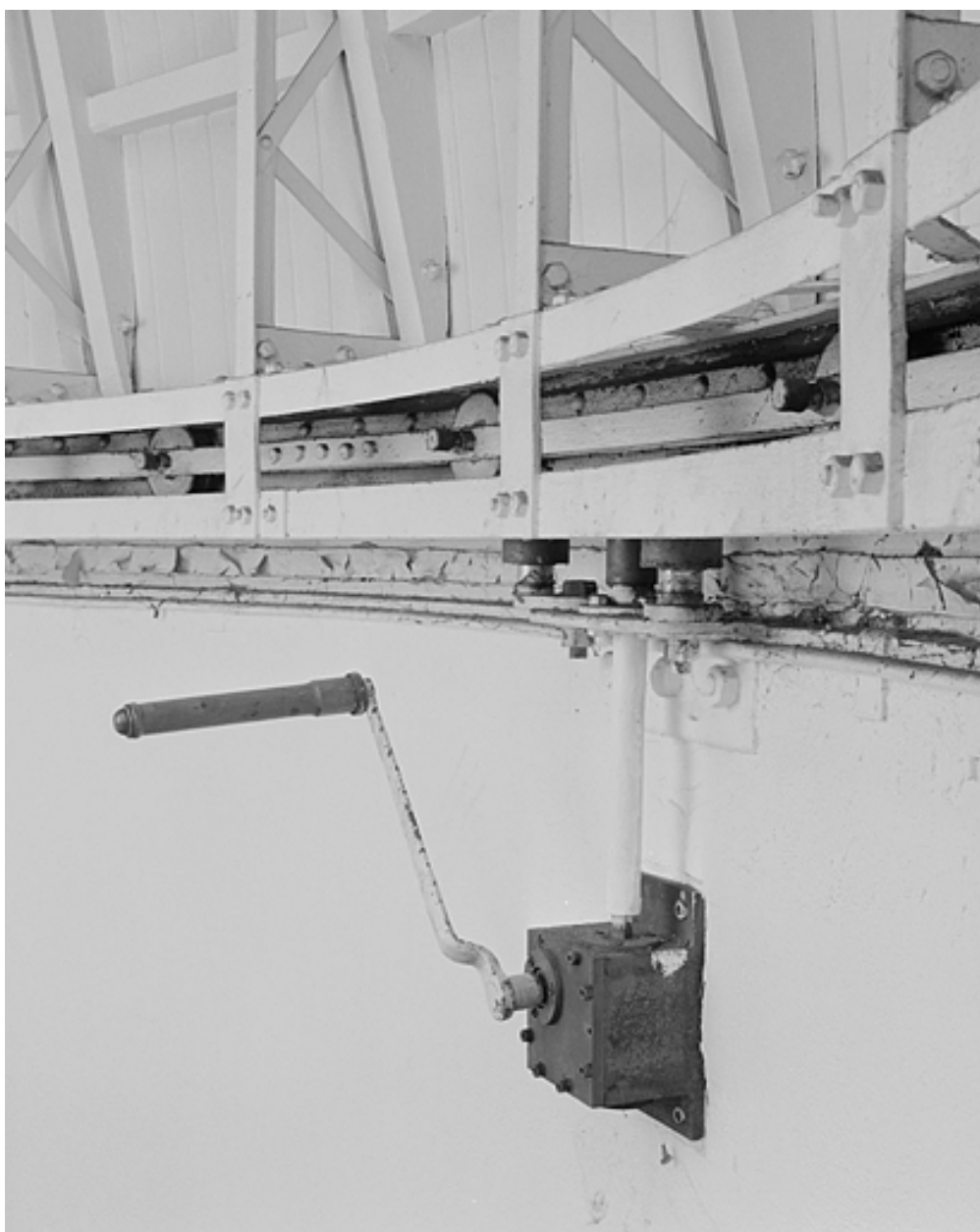
Système de rotation du dôme.
