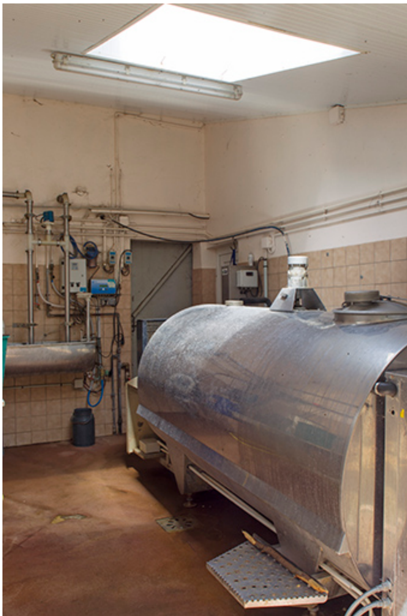
Tank à lait dans l'étable ouest.
