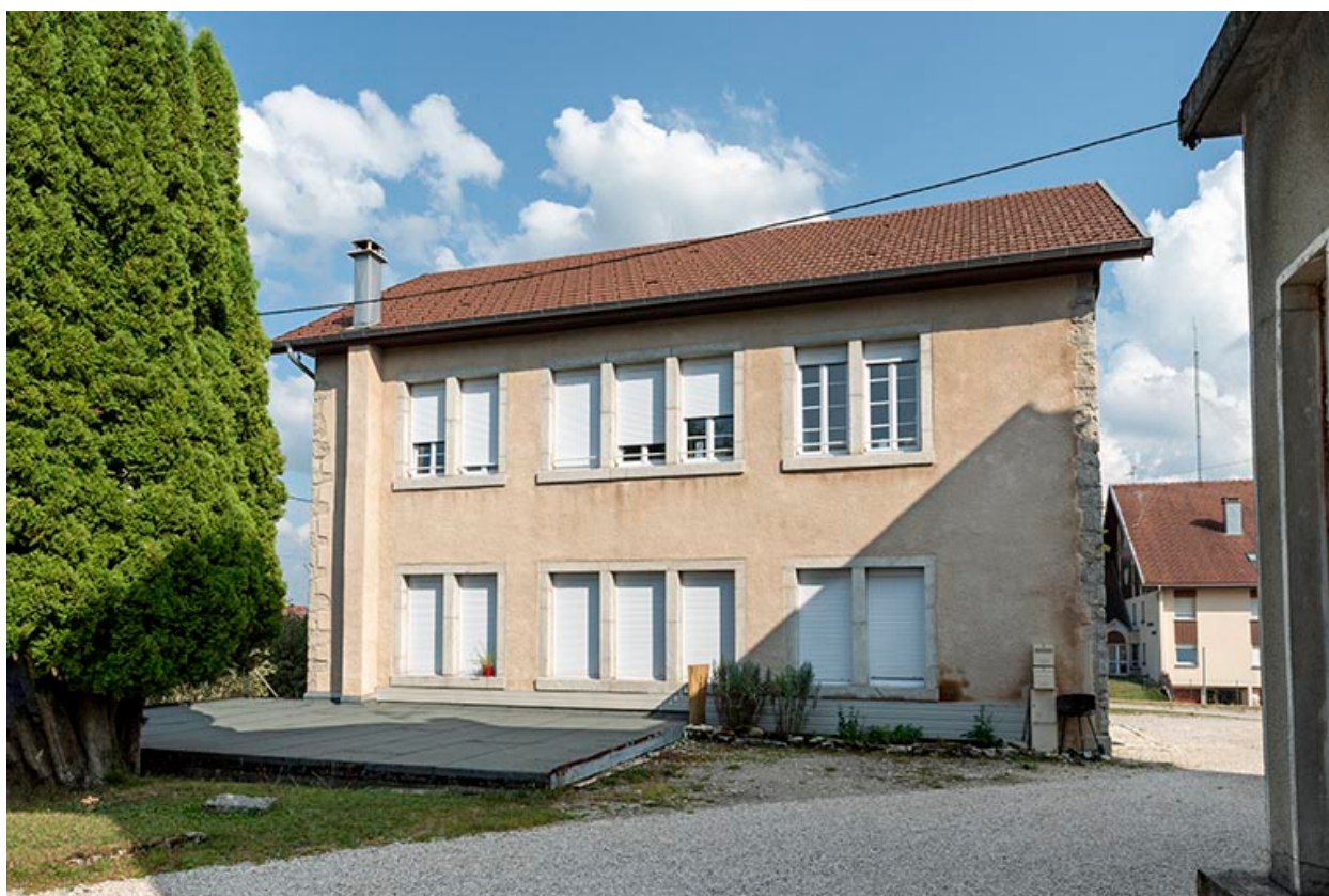
Atelier de fabrication : façade ouest.
