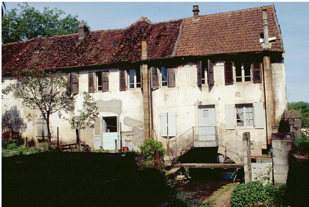
Bâtiment d'eau et logement depuis le sud-est.
