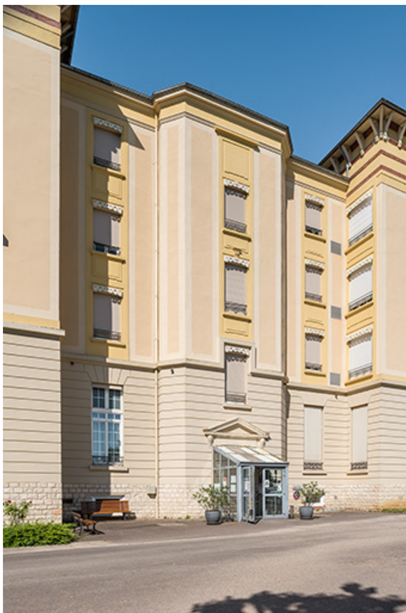
Façade nord-est avec l'entrée de l'escalier.
