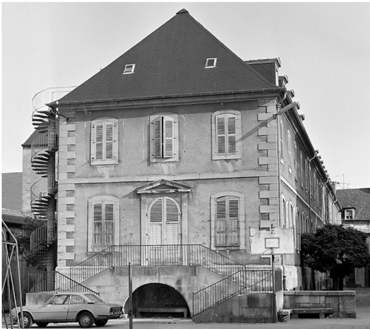
Bâtiment principal, façade sud.
