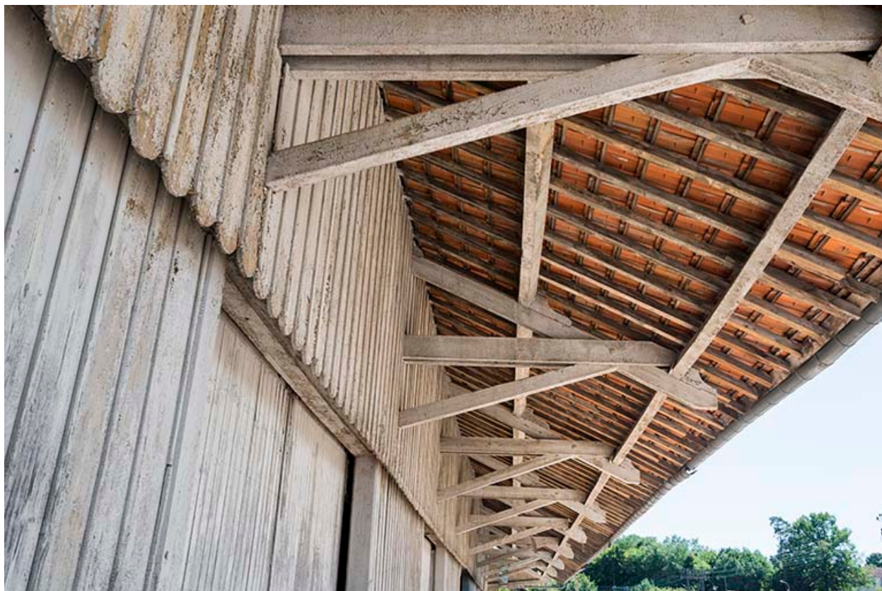
Détail de l'avant-toit de l'ancienne halle.
