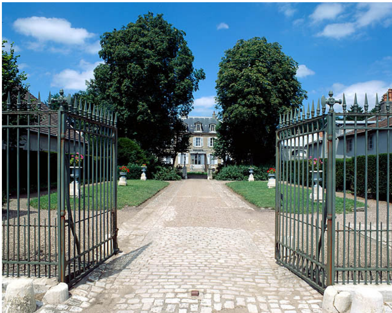
Bâtiment d'habitation depuis la grille d'entrée ouverte.
