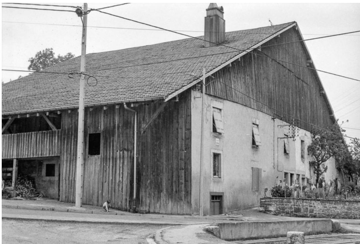
Façades antérieure et latérale gauche.
