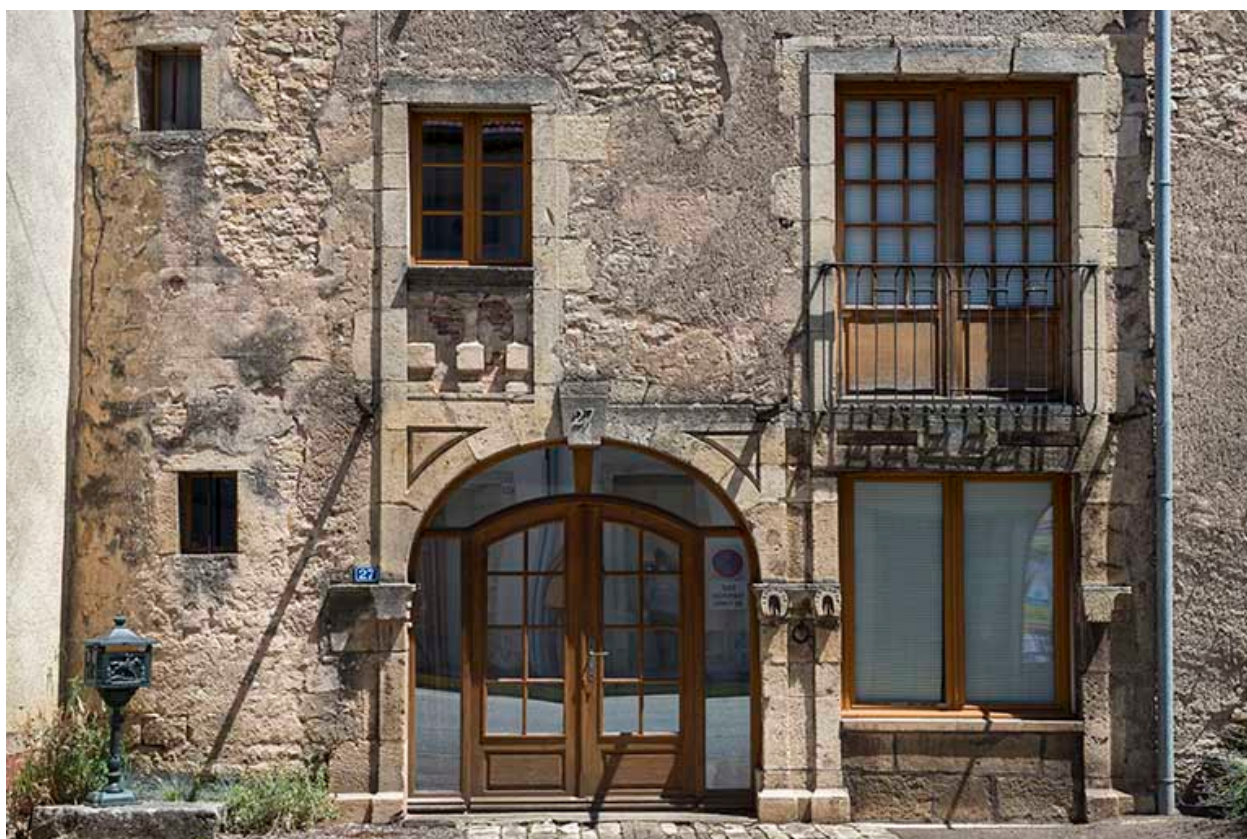
Baies du rez-de-chaussée et du premier étage.
