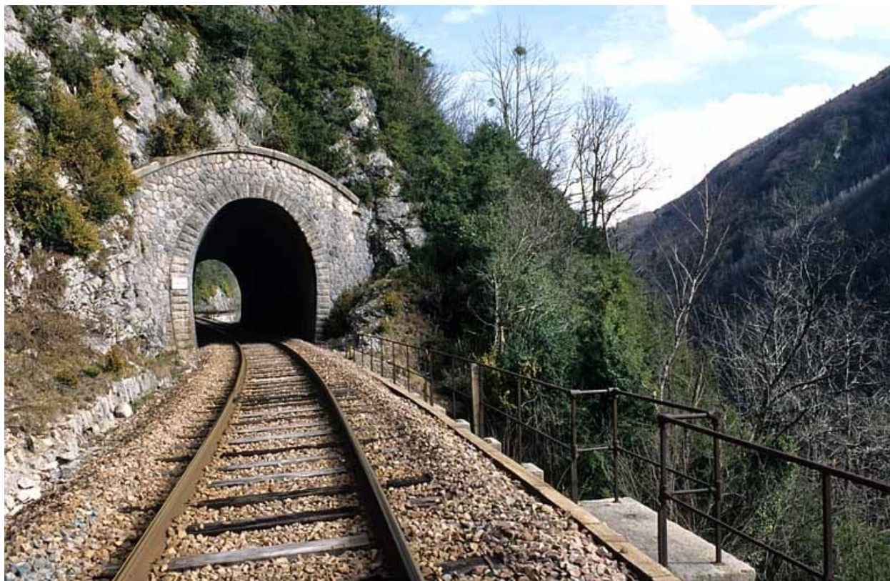
Tunnel du Champ de Bienne : tête côté La Cluse (sud). Mur de soutènement à gauche.
