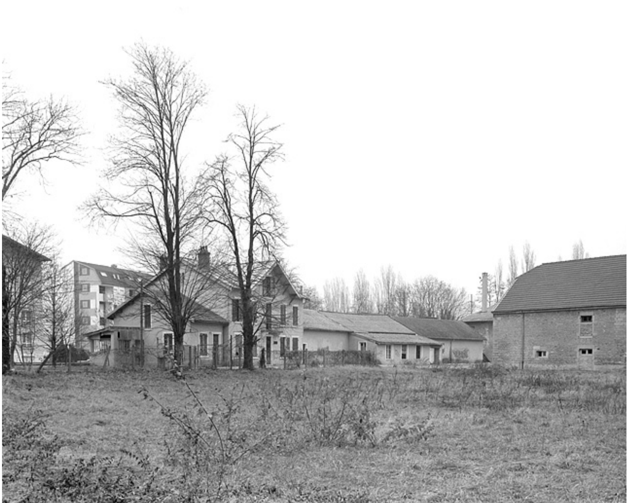
Logement, bureau et pièces d'affinage depuis l'ouest.
