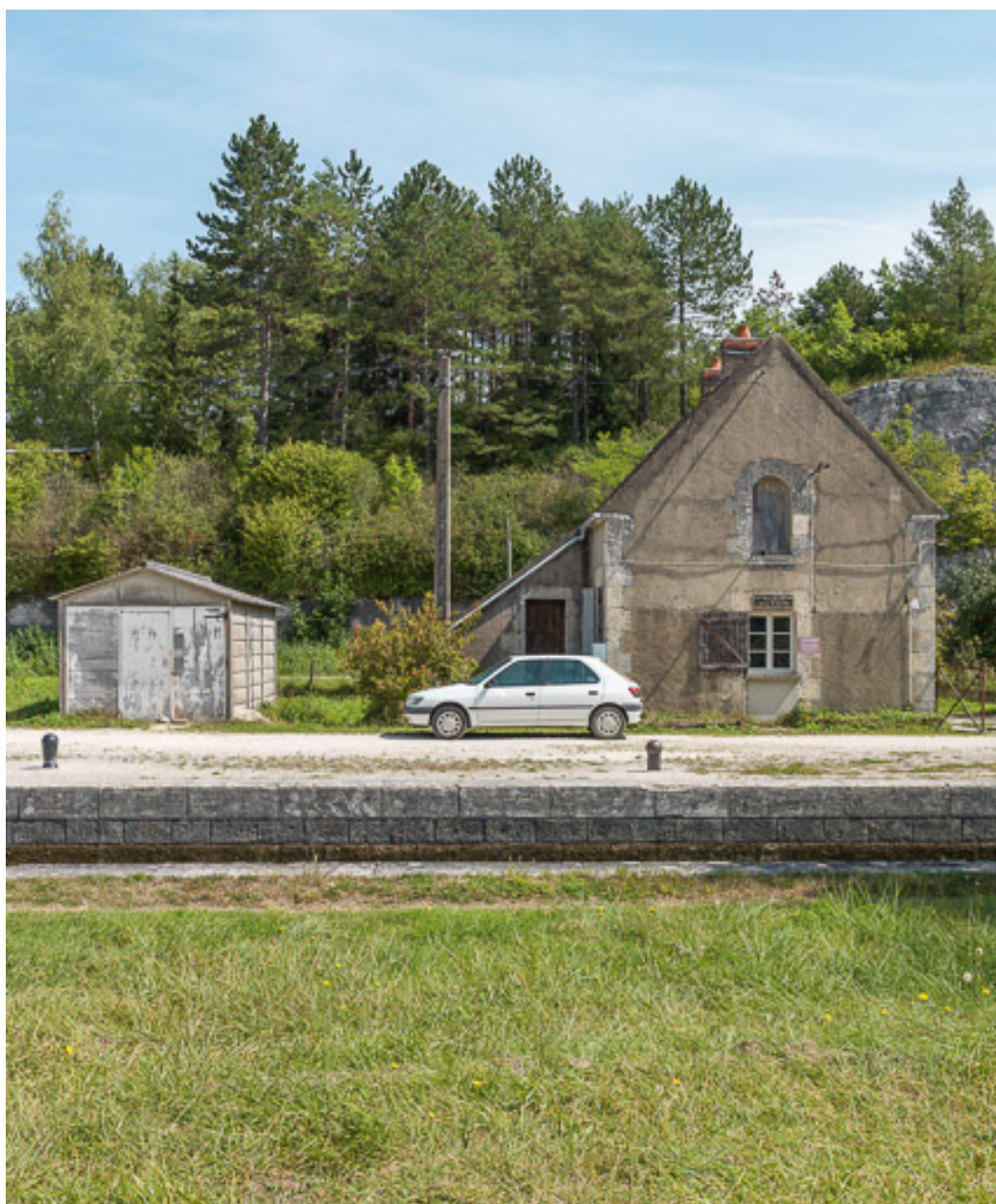
Vue de la maison éclusière.
