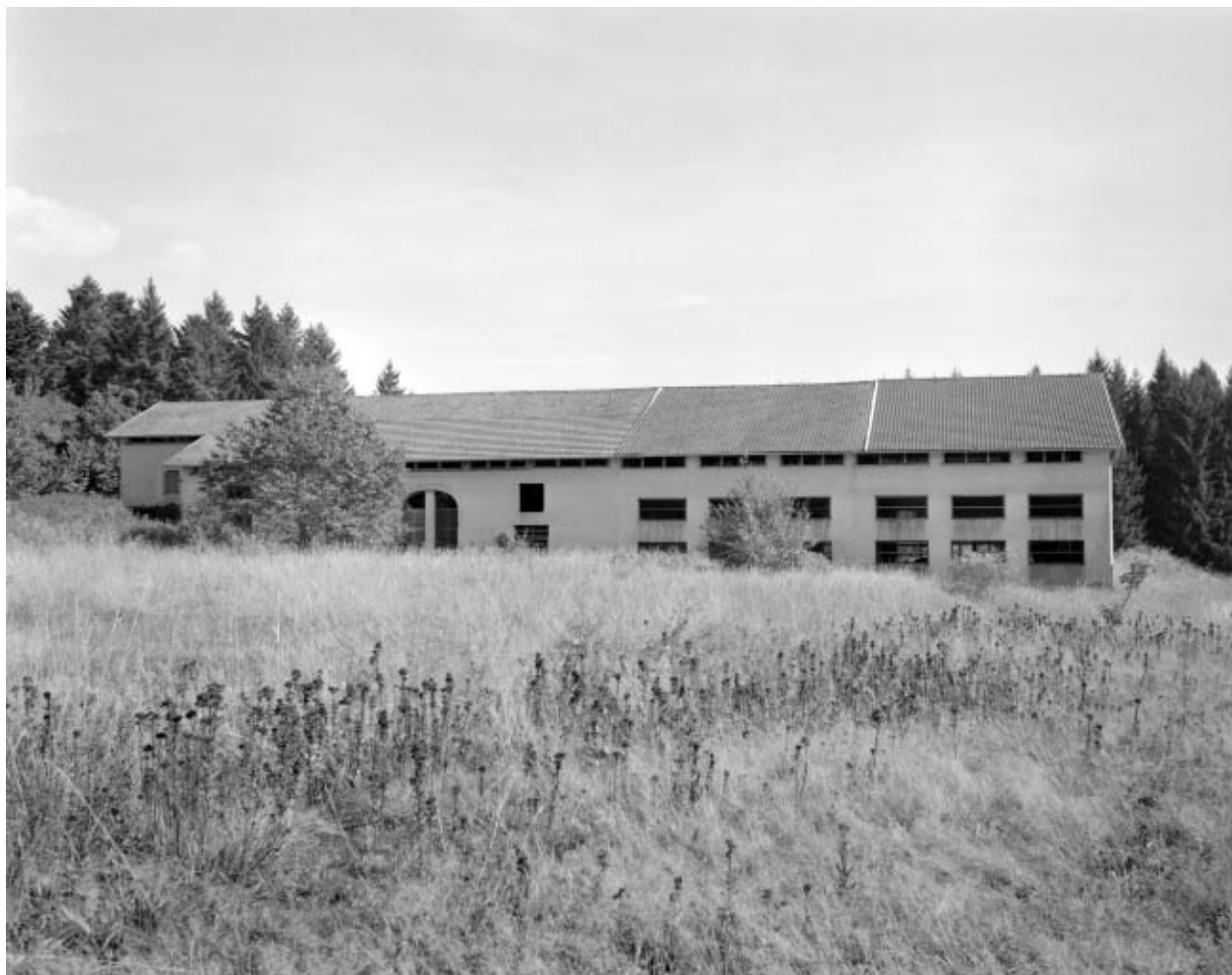
Façade postérieure du séchoir.
