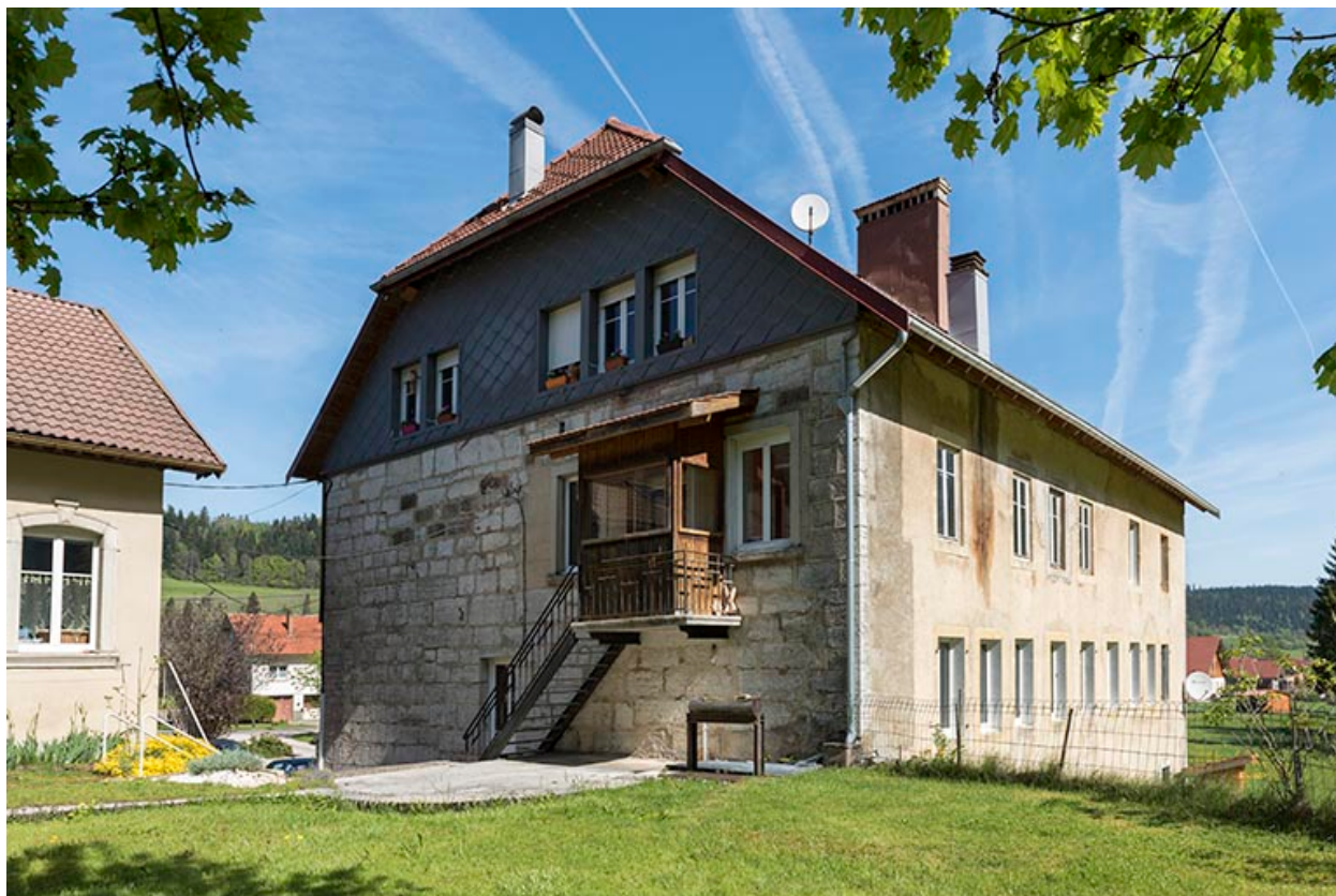
Chaudronnerie : façades postérieure et latérale gauche.
