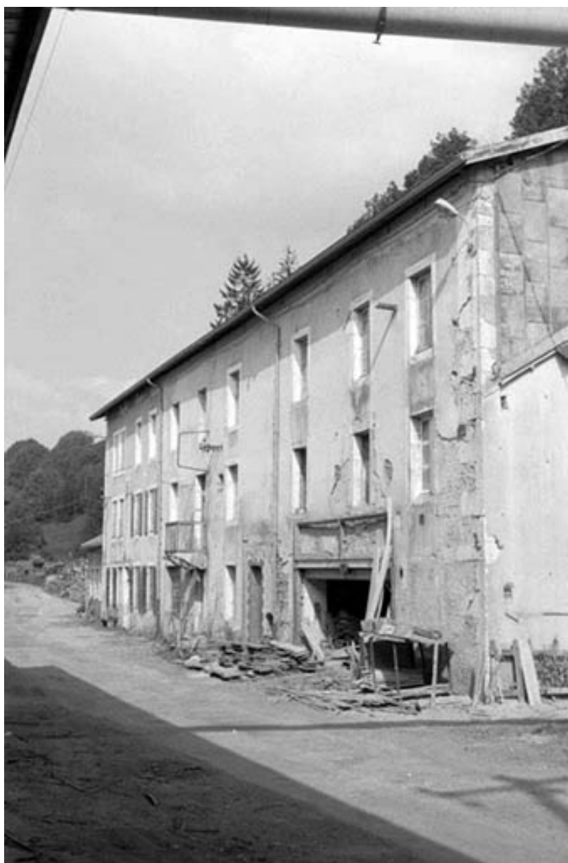
Ancien atelier de fabrication.
