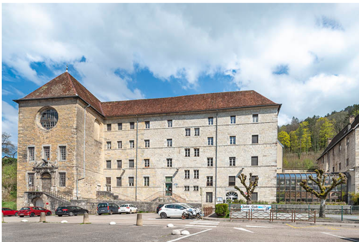
Vue depuis l'ouest.
