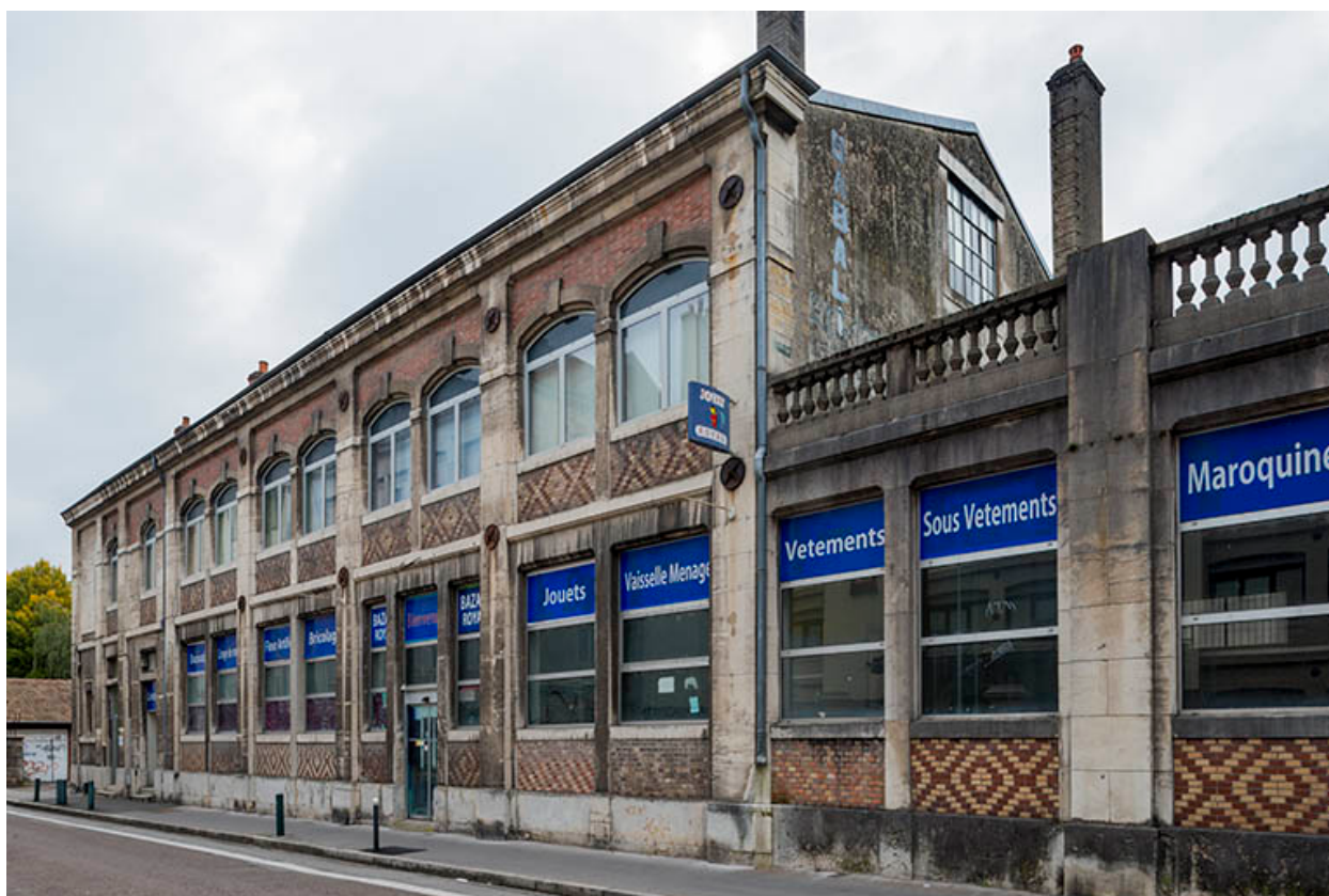
Vue rapprochée depuis le sud-ouest.
