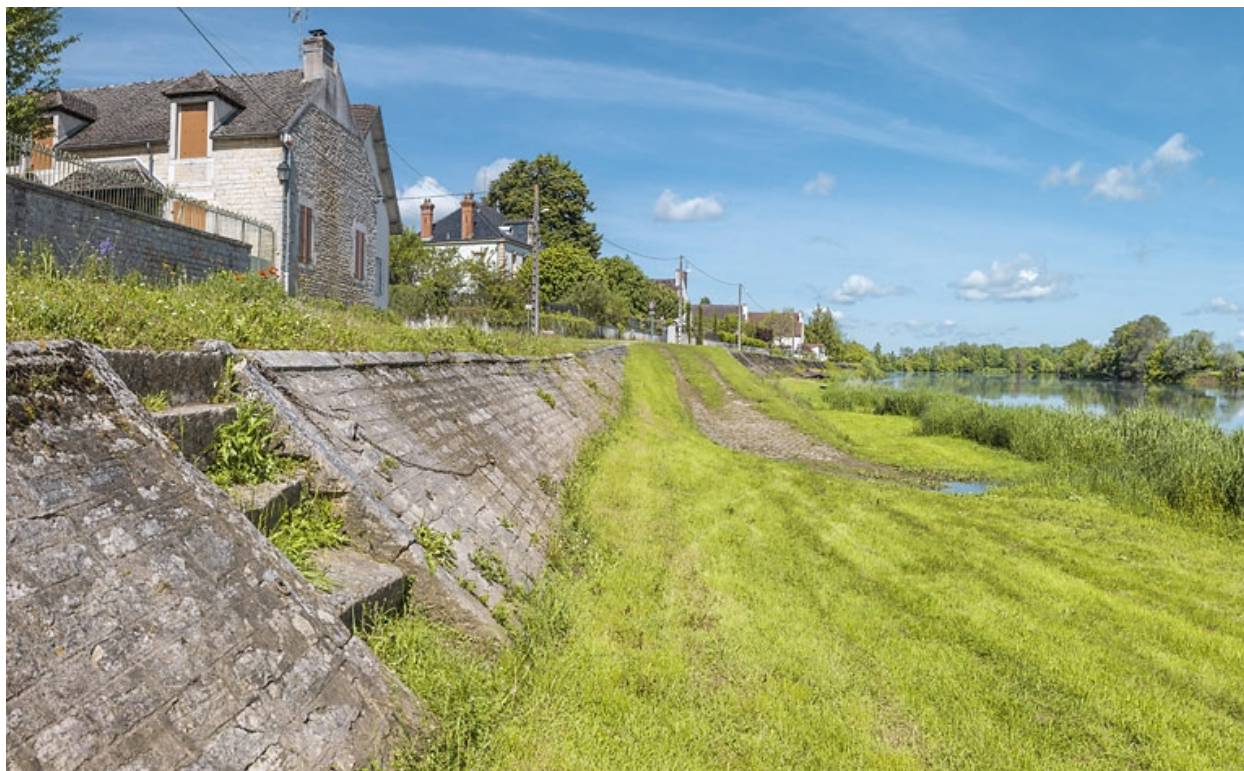
Escalier et rampe de la digue.
