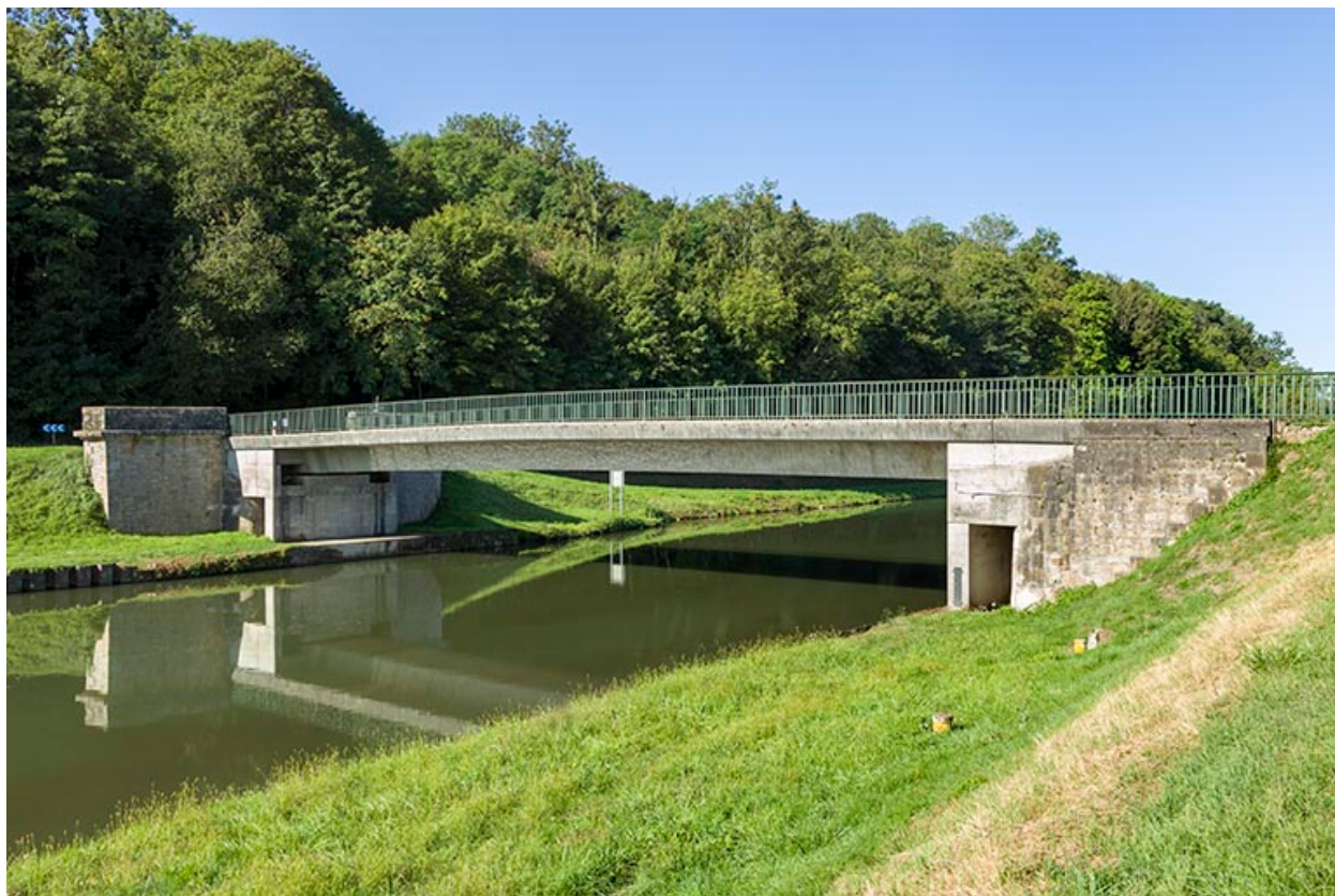
Pont de la D152 enjambant le canal.
