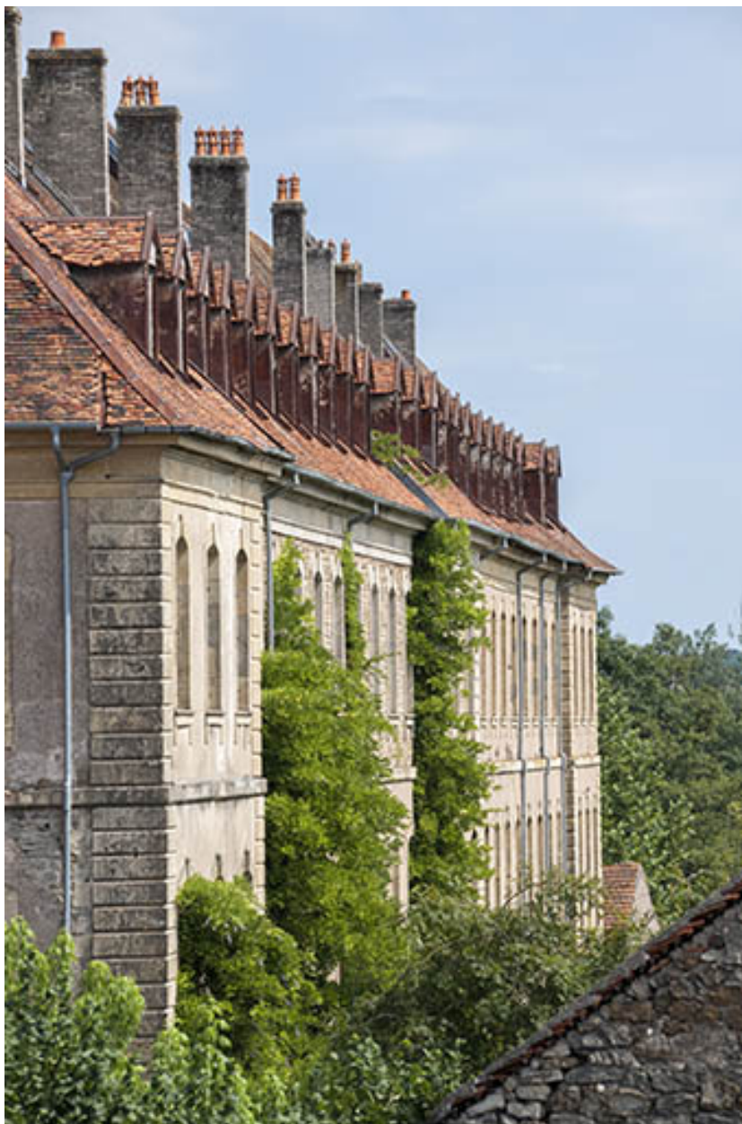
Vue rapprochée de la façade sud.
