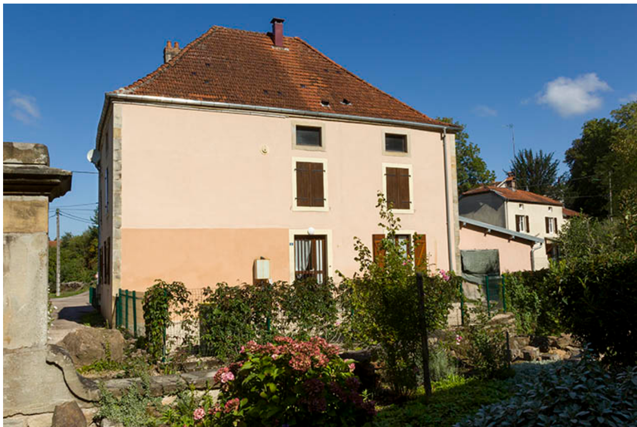
Maison, façade postérieure, rue du Moulin.
