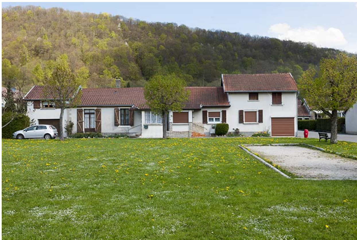
Maisons ouvrières donnant sur la place.
