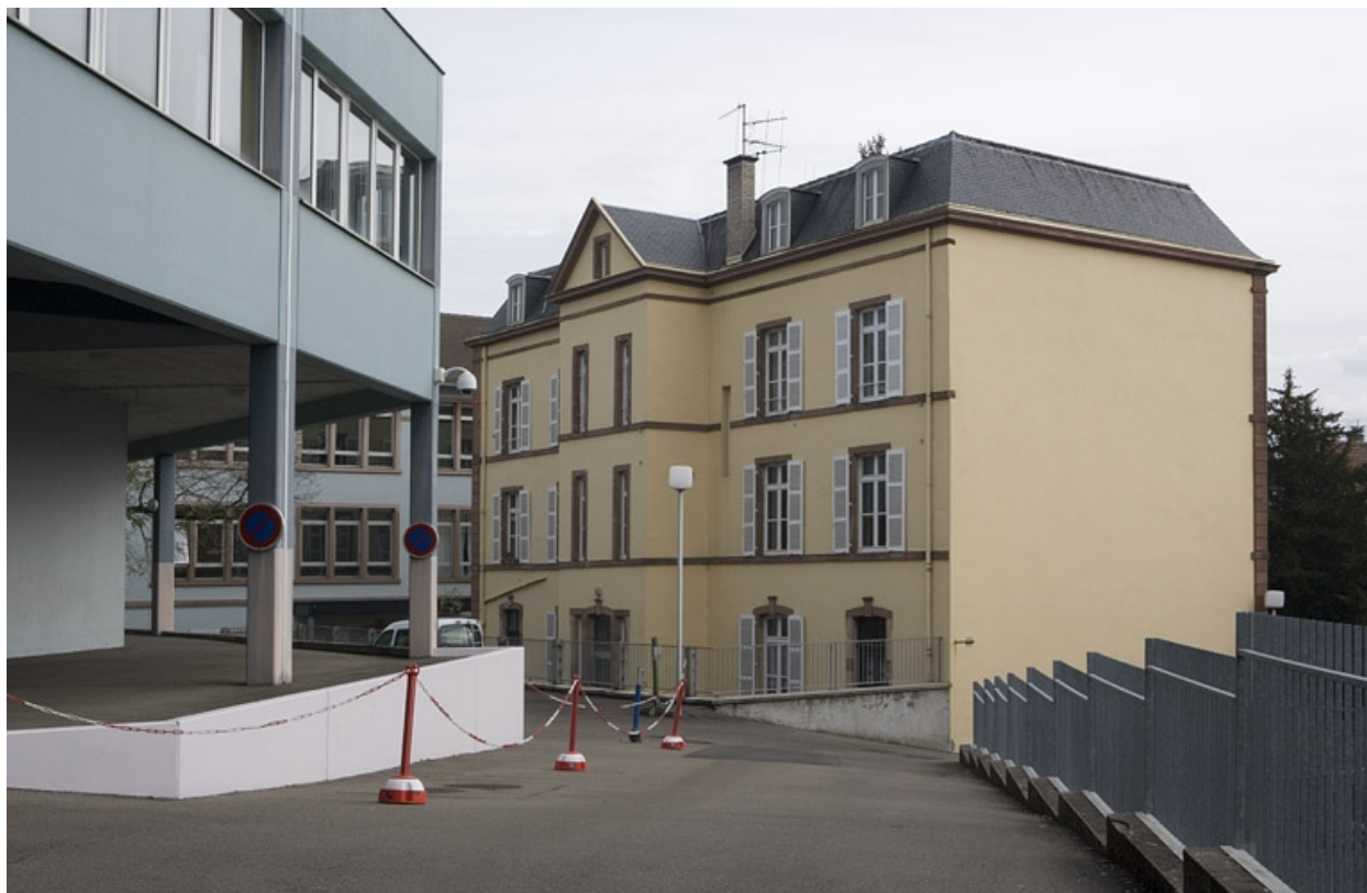
Vue extérieure bâtiment A trois quarts droit.
