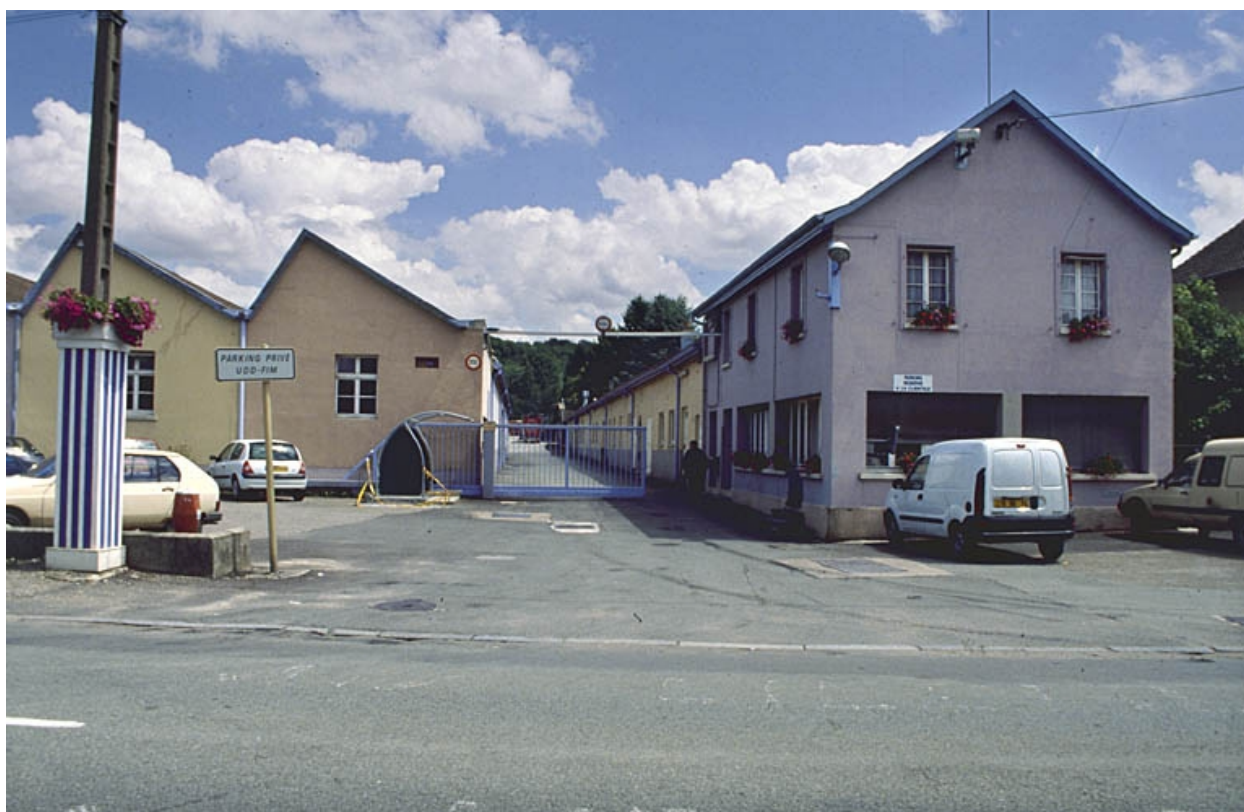
Entrée de l'usine.
