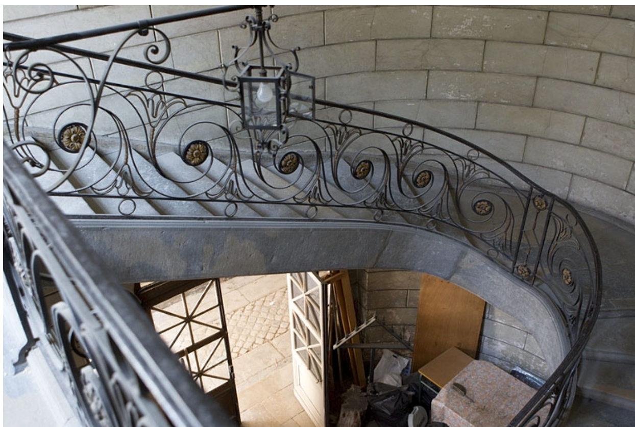
Intérieur : vue d'ensemble de l'escalier.
