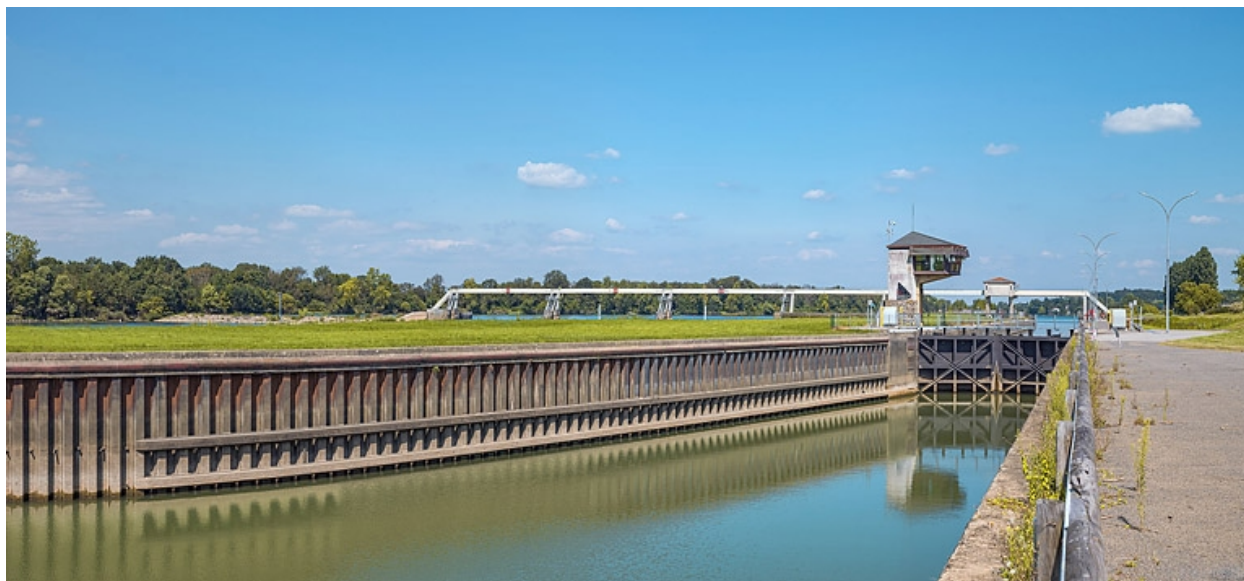
Tête aval de l'écluse.
